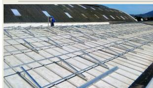
Estrutura Metálica Inclínada
